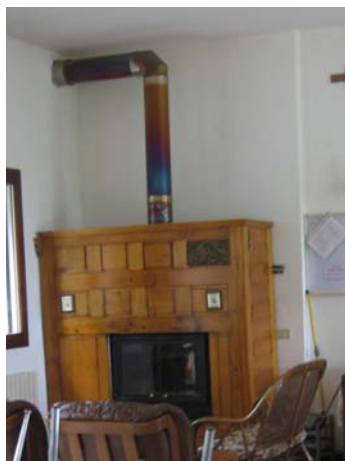
Cheminée permettant de chauffer toute la maison communautaire (Ferrara, Italie)
