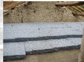
Des panneaux de métisse prêts pour isoler.
