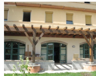
La façade sud de la maison de Pamplona (Espagne), de larges ouvertures, mais protégées par des brises soleil pour maîtriser les apports de chaleur et de lumière en fonction de la saison
