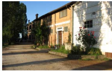
Maison Emmaüs Ferrara- Italie, réflexion sur l'isolation du bâtiment.
