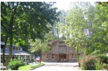
La casa de la comunidad de Haarzuilens (Holanda): de madera, con un techo vegetalizado
