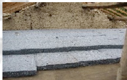
Paneles de mezcla prontos para aislar.
