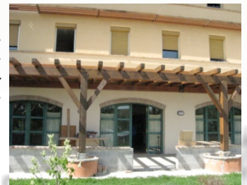
La fachada sur de la casa de Pamplona (España), amplias aperturas, pero protegidas por quiebrasoles para mantener los aportes de calor y de luz en función de las estaciones.
