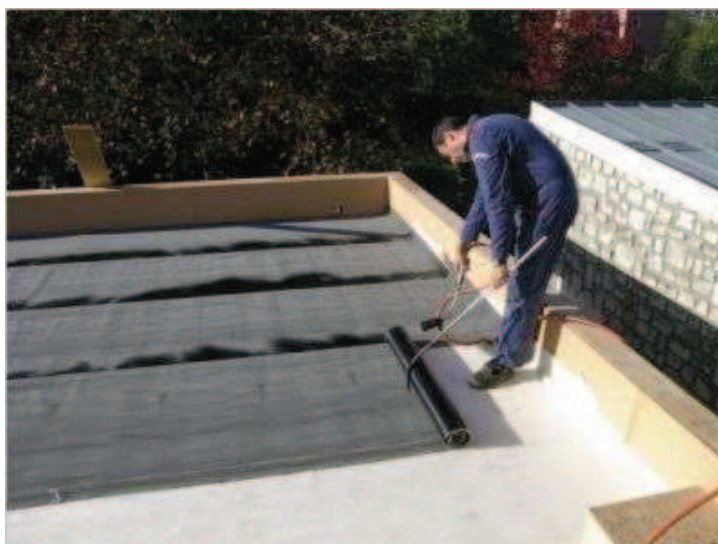
Figura 1. Instalación de una membrana impermeabilizante
