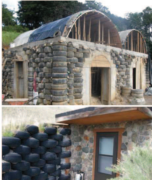
Figura 2. Utilización de neumáticos para la construcción de una casa
