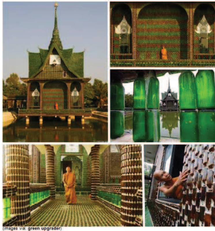
Figure 1. Temple bouddhiste construit avec des bouteilles en verre
