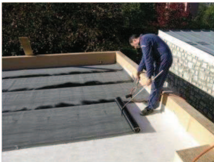
Figure 1. Installation d'une couche d'étanchéité
