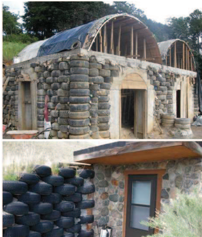
Figure 2. Utilisation de pneus pour la construction d'une maison
