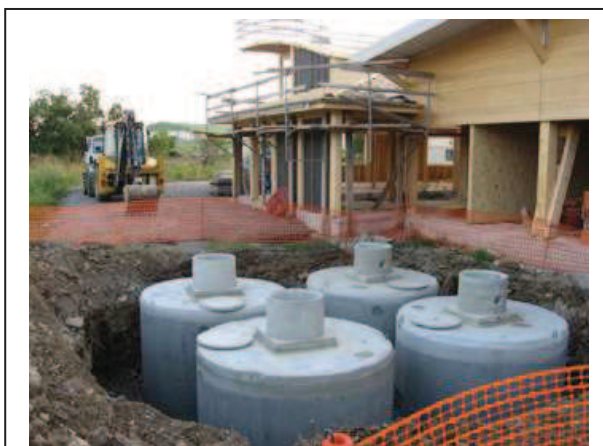
Figure 2. Cuves en béton (enterrées)
