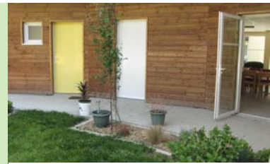
Emmaüs Angers – France, « résidence sociale » construite en rond, avec réflexion sur l'isolation.
