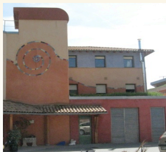
La façade sud de la maison de Pamplona (Espagne), de larges ouvertures, mais protégées par des brises soleil pour maîtriser les apports de chaleur et de lumière en fonction de la saison
